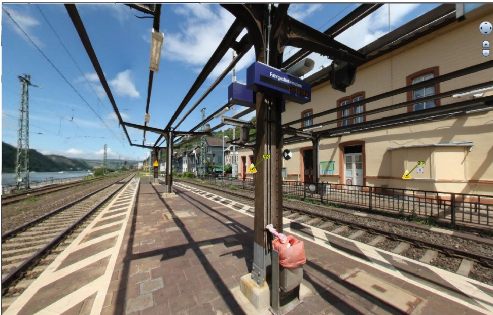
Abb. 3.1.7-1: Bahnhof Kaub: Punktwolke und HDR-Bild in Leica TruView.
