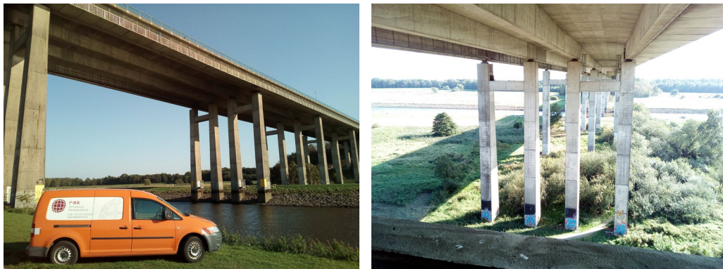
Abb. 3.1.10-1: Huntebrücke bei Oldenburg (A29).
