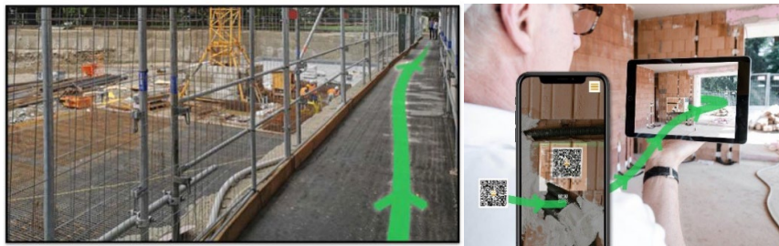
Abb. 3.2.12-3: AR-basierender „Digitaler Leitstrahl“ auf der Baustelle von Robotic Eyes GmbH.
