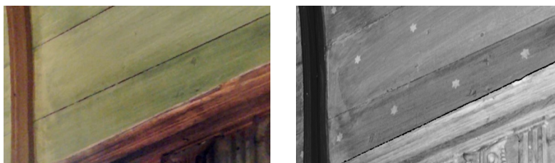
Abb. 3.1.6-5: im Intensitätsbild sichtbare Farbschicht mit Sternenhimmel.
