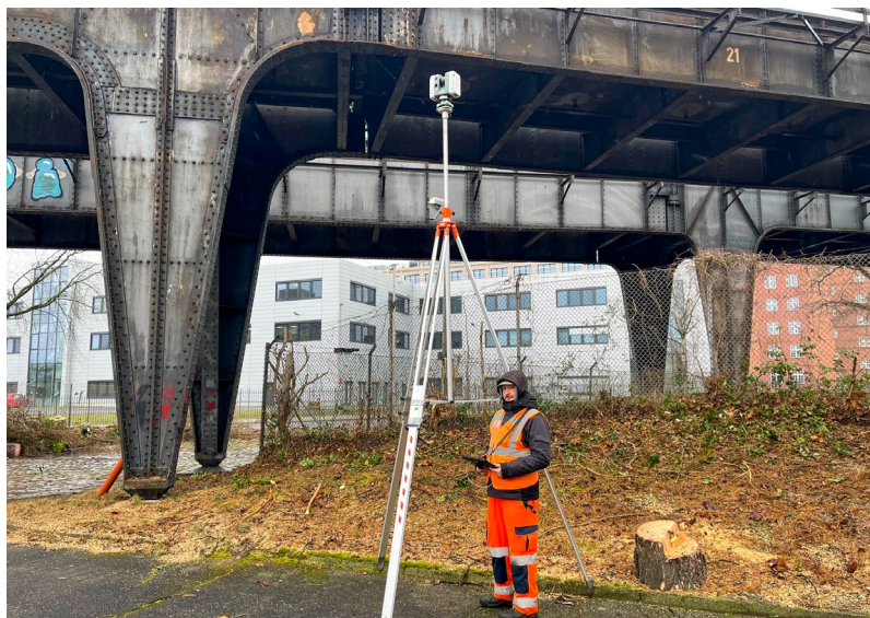
Abb. 3.1.20-1: 3D-Laserscan der Stahlviadukt Stützen aus verschiedenen Perspektiven.
