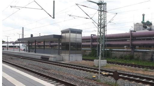
Abb. 3.1.19-4: Mittelbahnsteig nach dem Umbau.
