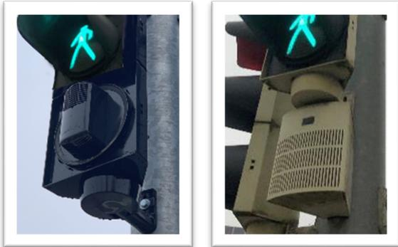
Abbildung 7: Ampelanlage mit einem akustischen Signalgeber
