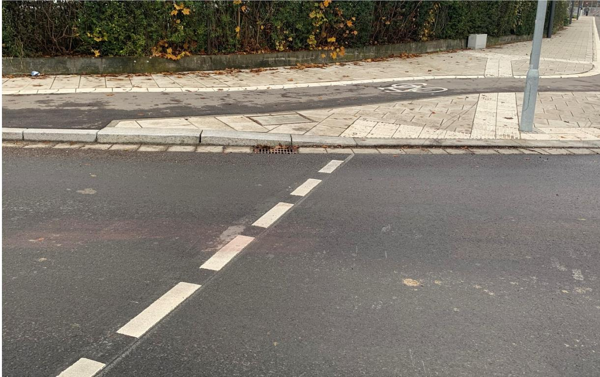
Abbildung 6: Barrierefreier Fußgängerübergang mit abgesenktem Bordstein und taktilen Leitelementen
