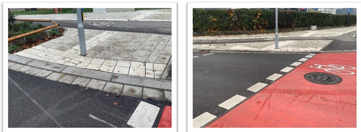
Abbildung 9: Taktile Bodenelemente
