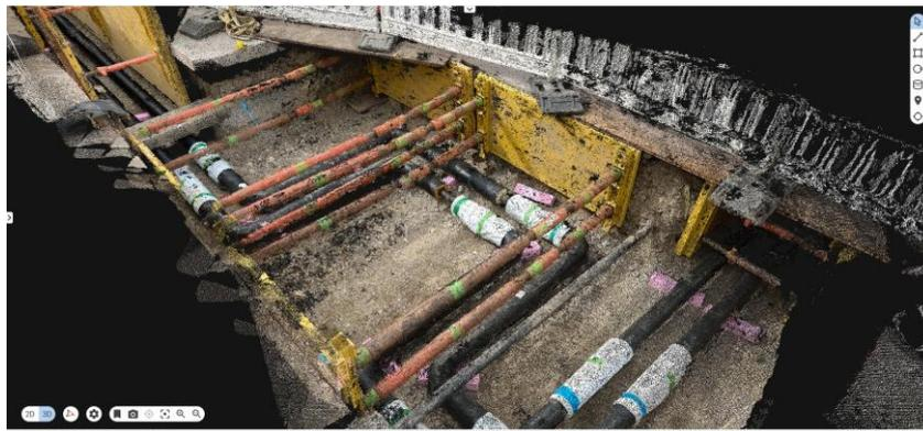
Abb. 3.1.19-3: Messergebnisse des 3D-Scannings in der Cloud
