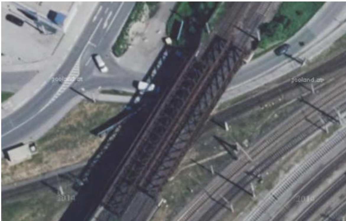
Abbildung 136: Bahnbrücke mit Eisenfachwerk
