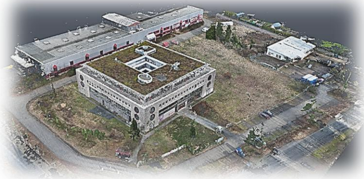
Abb. 3.1.6-3: Akademiegebäude aus terrestrischer und UAS- Photogrammetrie
