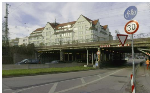
Abb. 3.1.5-1: Blick auf Eisenbahnüberführung Lindwurmstraße
