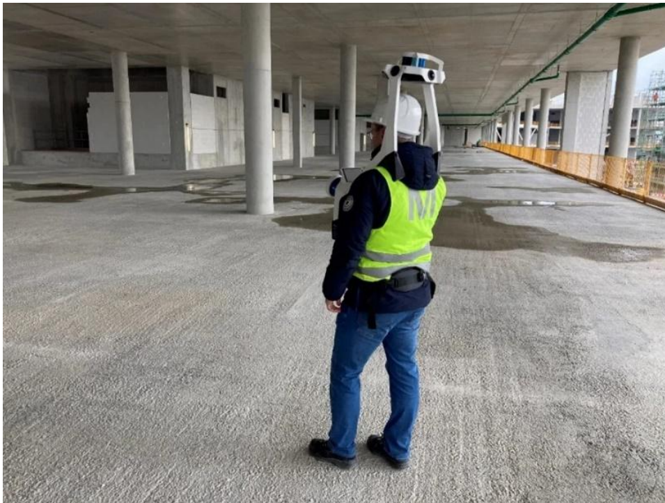
Abb. 3.1.4-1: Scannen auf der Baustelle mit dem NavVis VLX
