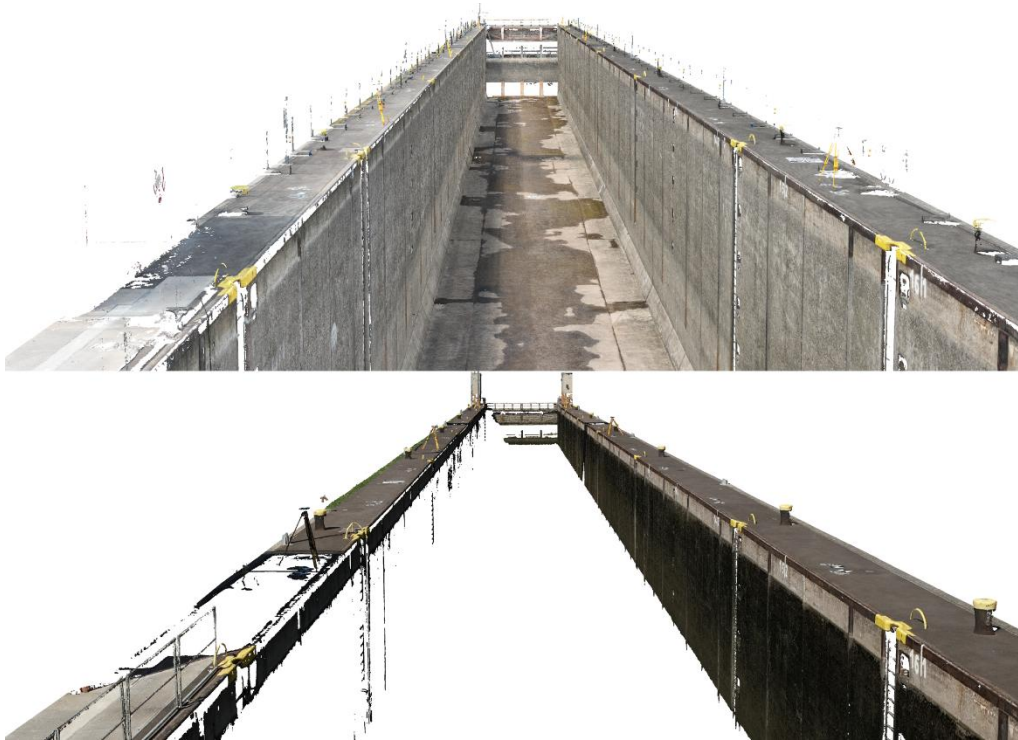
Abbildung 2.3.1 - 2: Punktwolken einer Schleusenammer aus UAS-Befliegungen. Oben: trockengelegte Kammer mit abgetrockneten Wänden und Restwasser auf der Sohle. Unten: nasse Kammerwände nach Absenken des Wasserstandes und ohne Adaption der Beleuchtung und Flugplanung.
